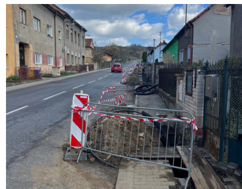
Rekonstrukce VO v obci
