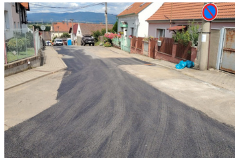
Rekonstrukce vpustí Světec
